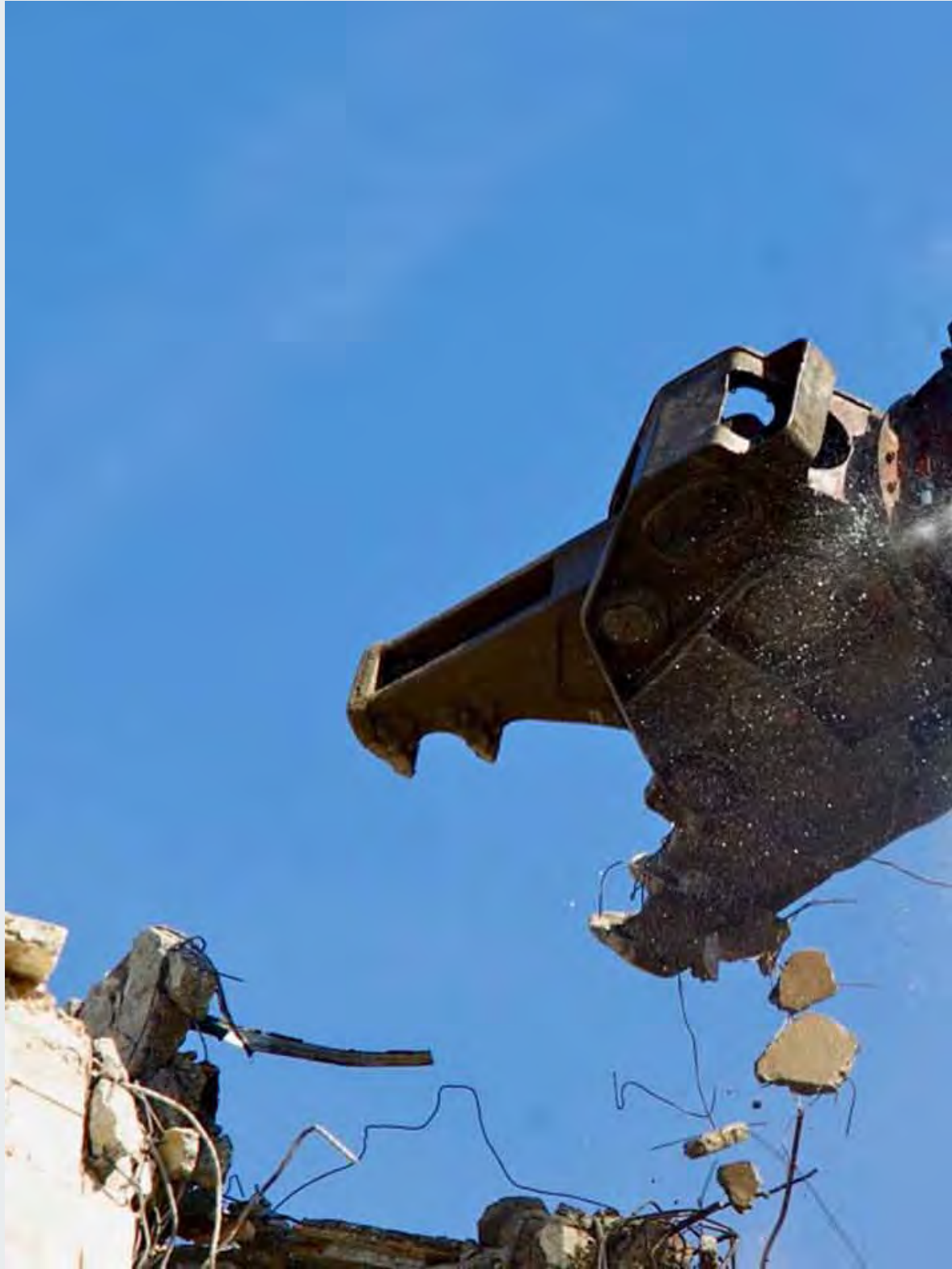
Le retour du ferruginovore cracheur
